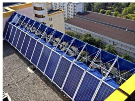
Installés sur l'arête du toit, les modules combinent solaire, éolien et d'autres fonctions. DR
