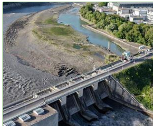
Barrage de Verbois (GE)
